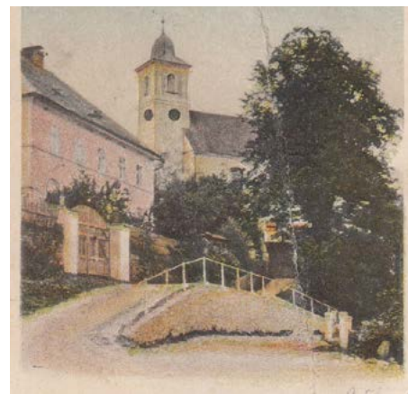
► Fara s kostelem, kolorovaná pohlednice kolem roku 1900
