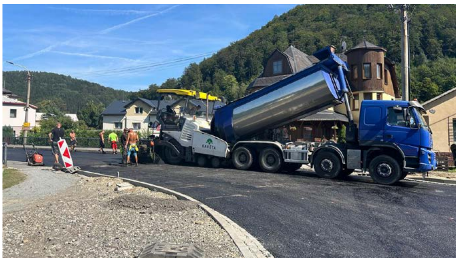
► Oprava Hlavní ulice byla nejnáročnější investicí Hanušovic za poslední roky. Samotnou vozovku rekonstruoval Olomoucký kraj, všechno okolo, včetně kanalizace a osvětlení, pak hanušovická radnice. foto:red
