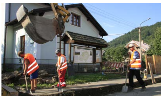
► Po dokončení výkopových prací získá ulice novou cestu i chodník.
