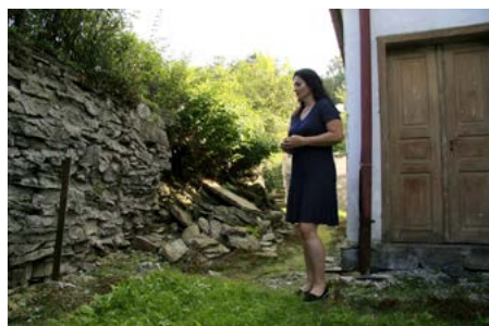
► Část hřbitovní zdi se už sesula. Podle Marie Pecháčkové, projektové manažerky města, bude právě rekonstrukce okolí hřbitova jedním ze stěžejních bodů celé revitalizace.
