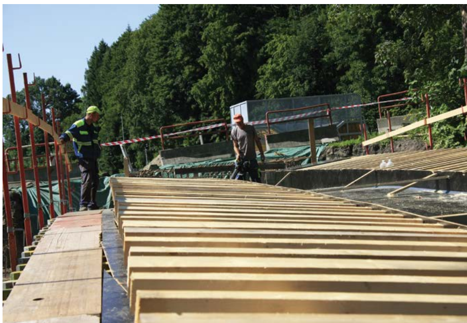
► V polovině července byla lávka těsně před betonáží hlavní konstrukce.
