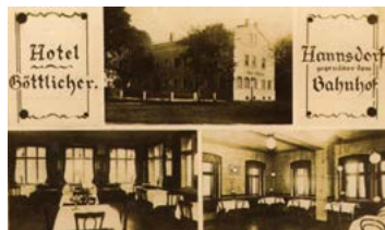
14 - Hotel Göttlicher s interiéry po přístavbě – pohlednice, 20. léta 20. století.
