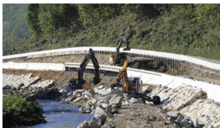
► Opravu silnice komplikuje zpevnění svahu, který s ní sousedí. Foto: red
