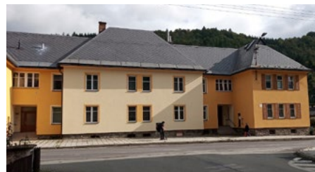
► Díky opravě fasád podporované městem prokoukla i hlavní ulice v Hanušovicích. Foto: red
