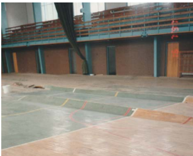
► Tělocvična v červenci 1997
