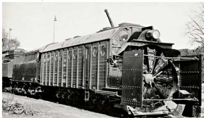
Henšl – sněhová fréza na parní pohon používaná na trati Hanušovice Ramzová až do 70. let 20. století
