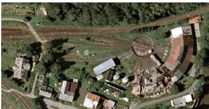
Hanušovické lokomotivní depo před zbouráním
